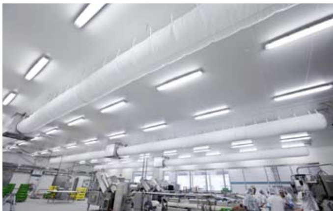
Fertigung und Montage der Brucha-Paneelen für Kühl- und Tiefkühlräume – Innenausbau Decken und Wände durch das BRUCHA-Montage-Team.
